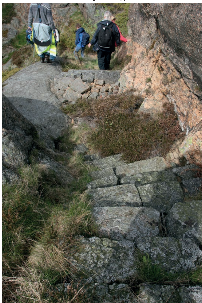
Under: Veien ned er forsøkt anlagt med trapper av store steinblokker.
