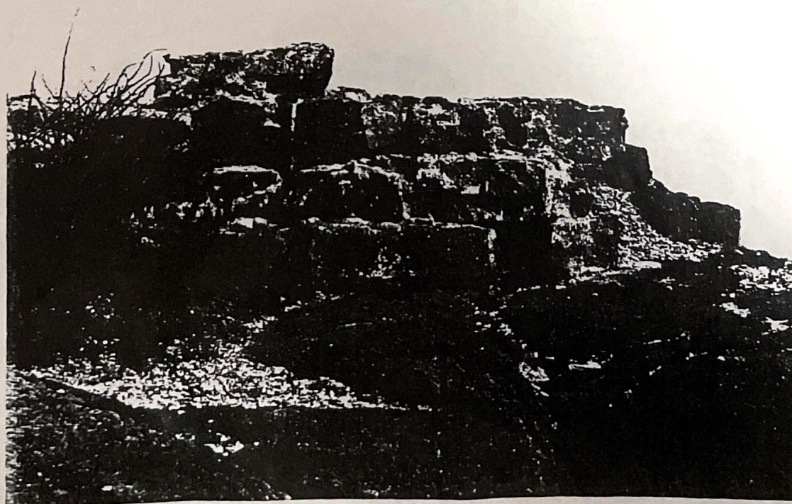
Ruinens fasade mot sør
